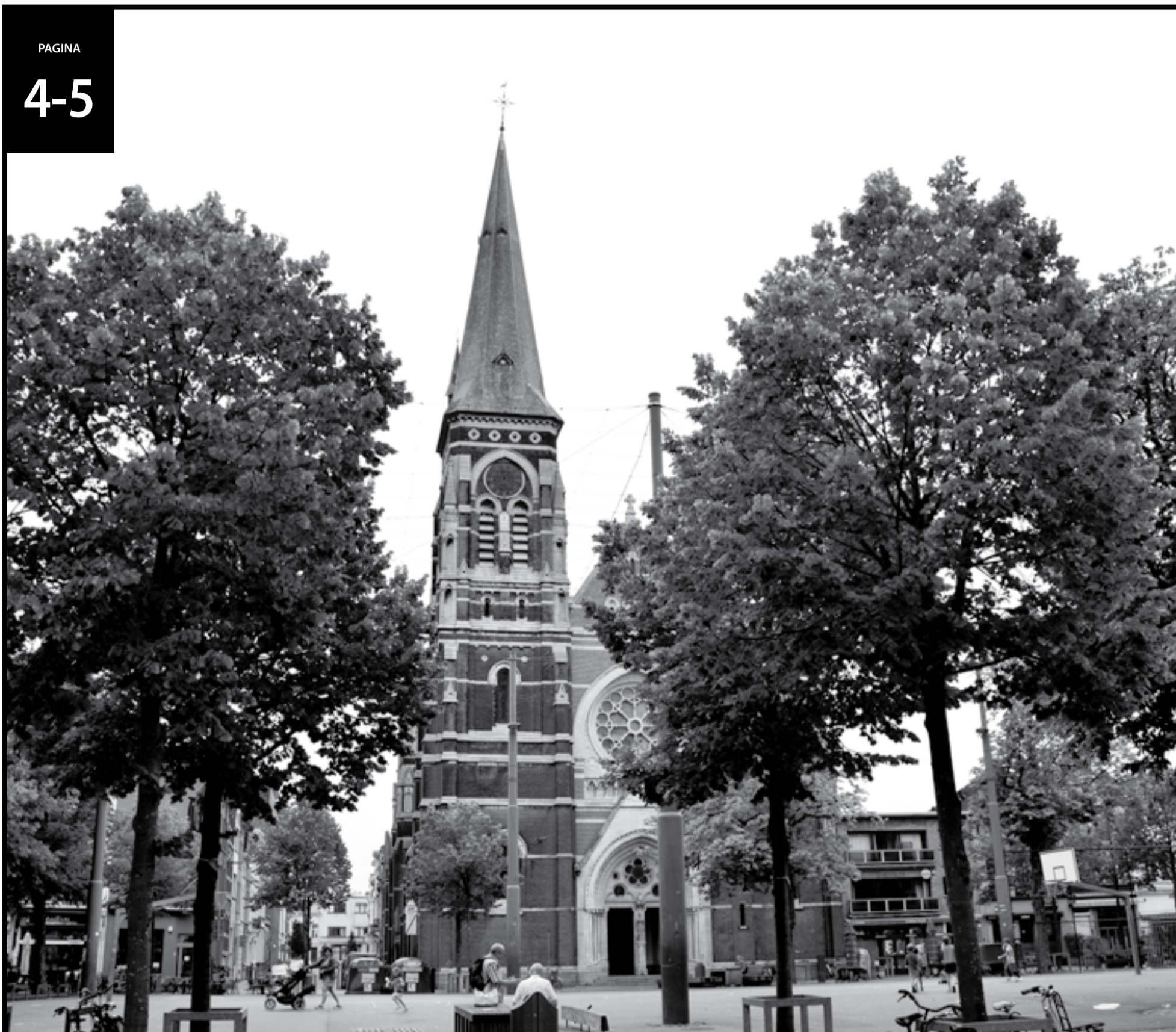
De Sint-Norbertuskerk wordt grondig gerestaureerd en dat zal ondermeer een gloednieuw torenuurwerk opleveren. • Foto Jörg PYL
