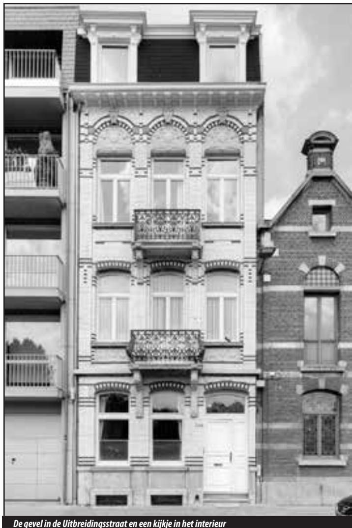
De gevel in de Uitbreidingsstraat en een kijkje in het interieur
